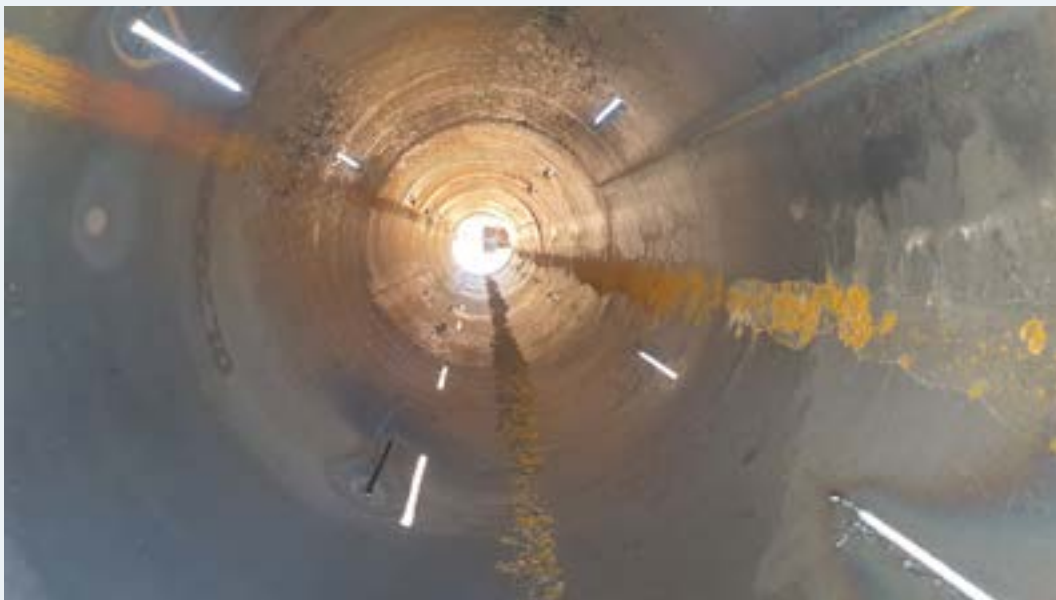
Vista interior de una tubería ranurada.
