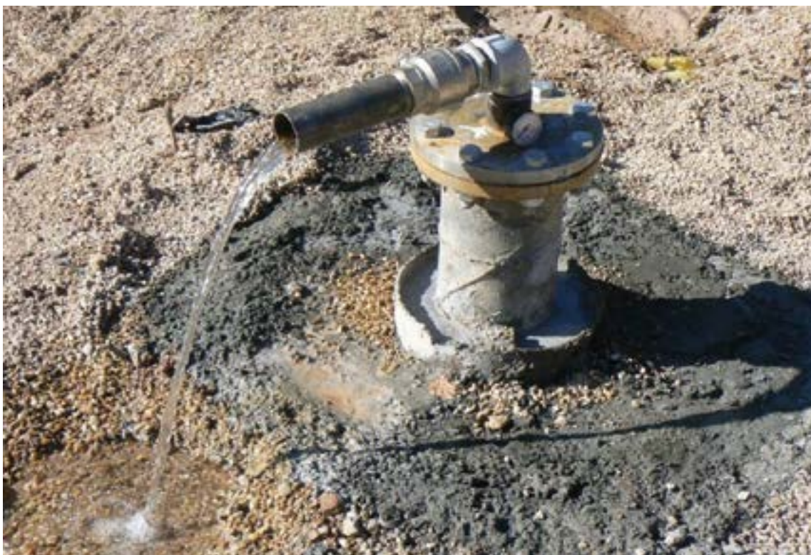
Detalle de la cimentación y el cierre de un pozo surgente. Autor: Víctor Del Barrio.
