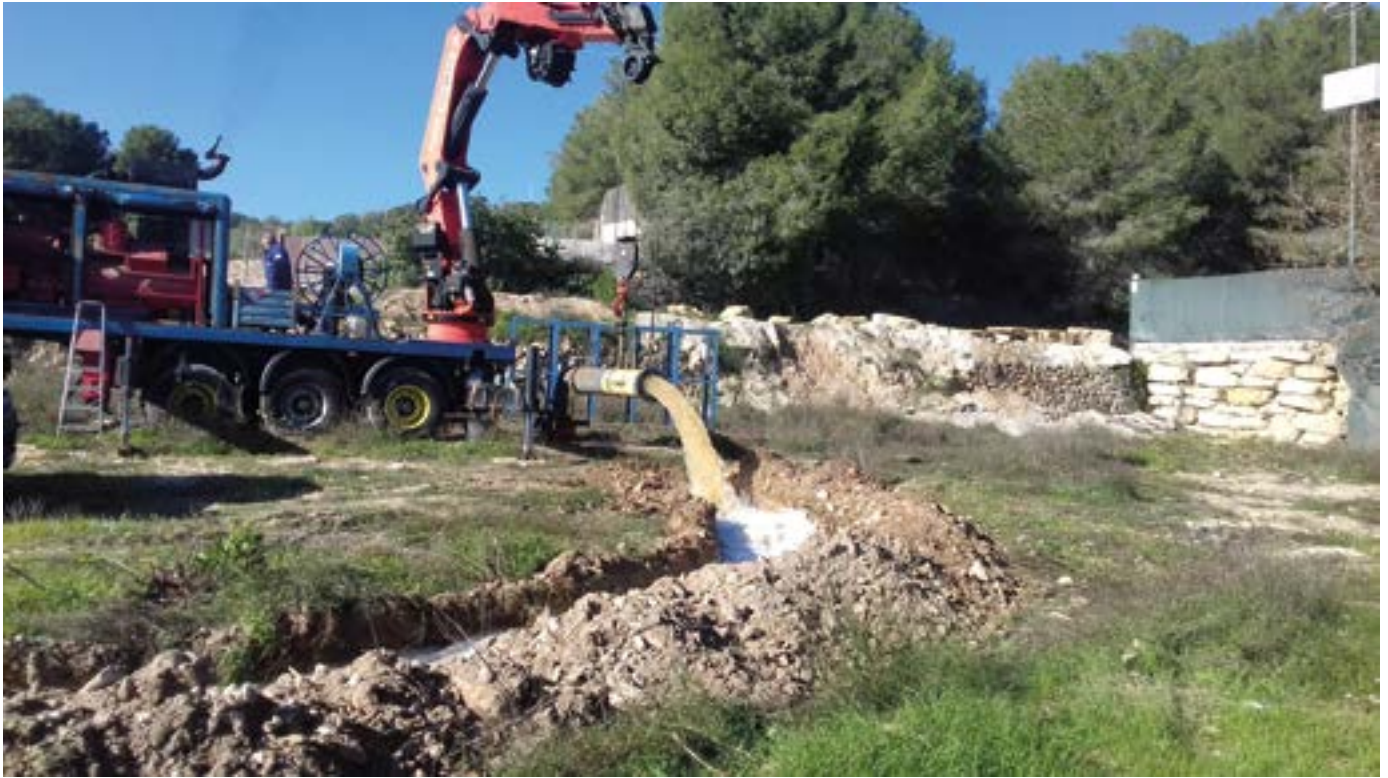
Ensayo de bombeo con evacuación del agua mediante una zanja. Autor: Eduardo Dorizzi.
