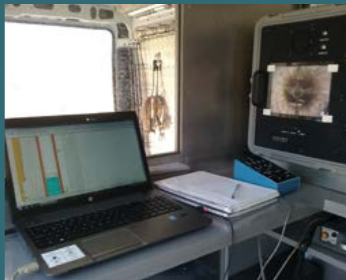
Sala de telecontrol de un equipo de diagraffas. Fuente: AQUATEC.
