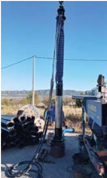
Instalación de un equipo de bombeo.
