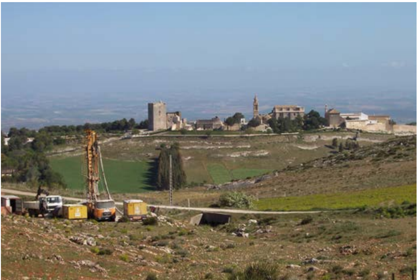
Equipo de perforación realizando un sondeo (Sierra de Estepa, Sevilla). Autor: Sergio Martos-Rosillo.
