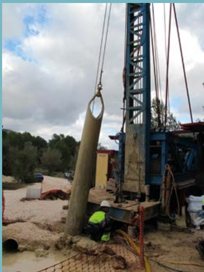
Detalle de la válvula de cuchara de un sondeo perforado a percusión. Autor: Juan Antonio Hernández Bravo.
