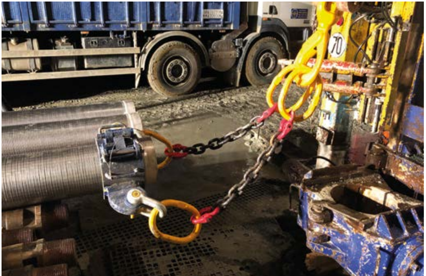
Detalle de la abrazadera para el descenso de una tubería de filtro tipo Johnson. Autor: Juan Franqueza.
