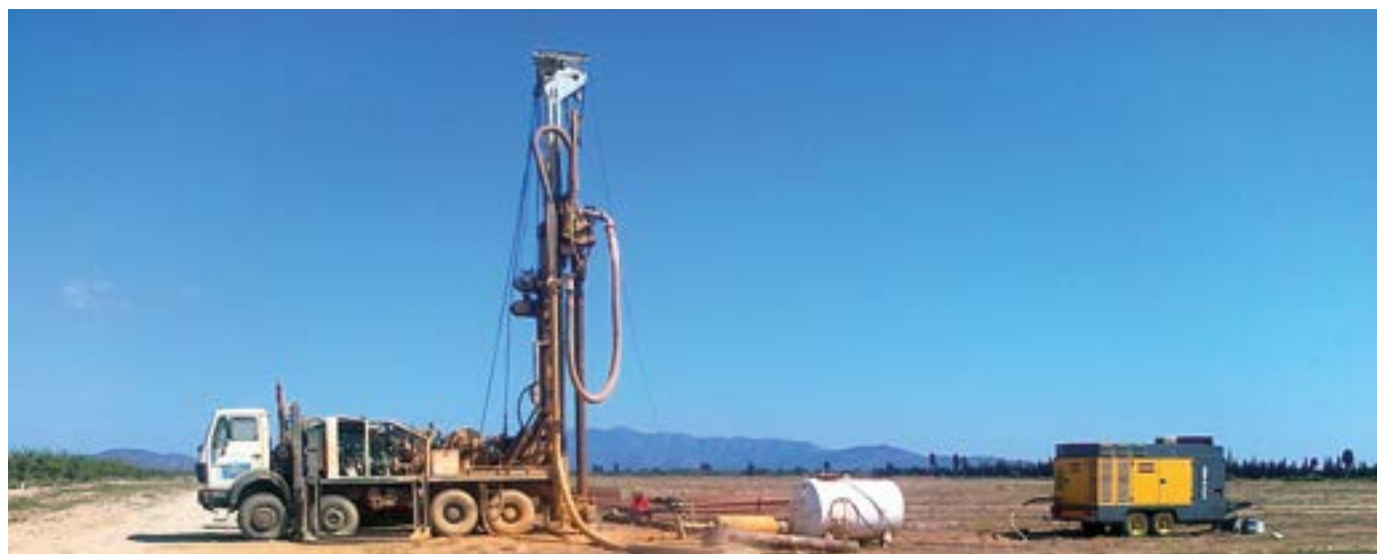
Equipo de perforación de rotación y rotopercusión en circulación inversa. Autor: Pedro Romero.
