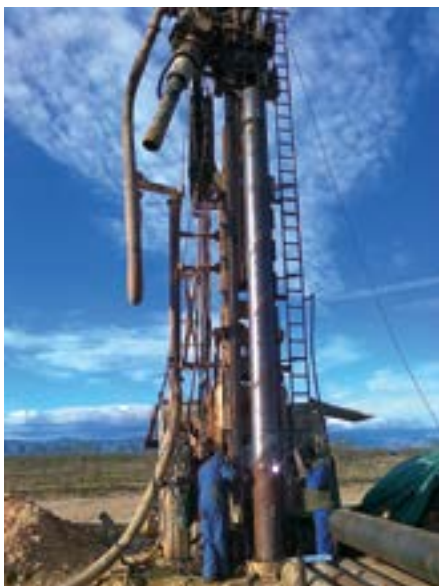
Soldadura para unión de tubería metálica.
