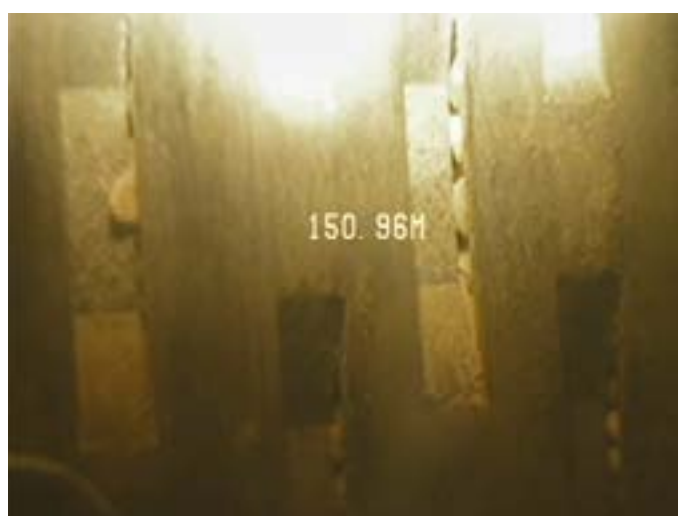
Tramo de filtro tipo puentecillo con un correcto estado de limpieza y desarrollo , se observa incluso el detalle de la grava del filtro a través de los puentes. Fuente: AQUATEC.
