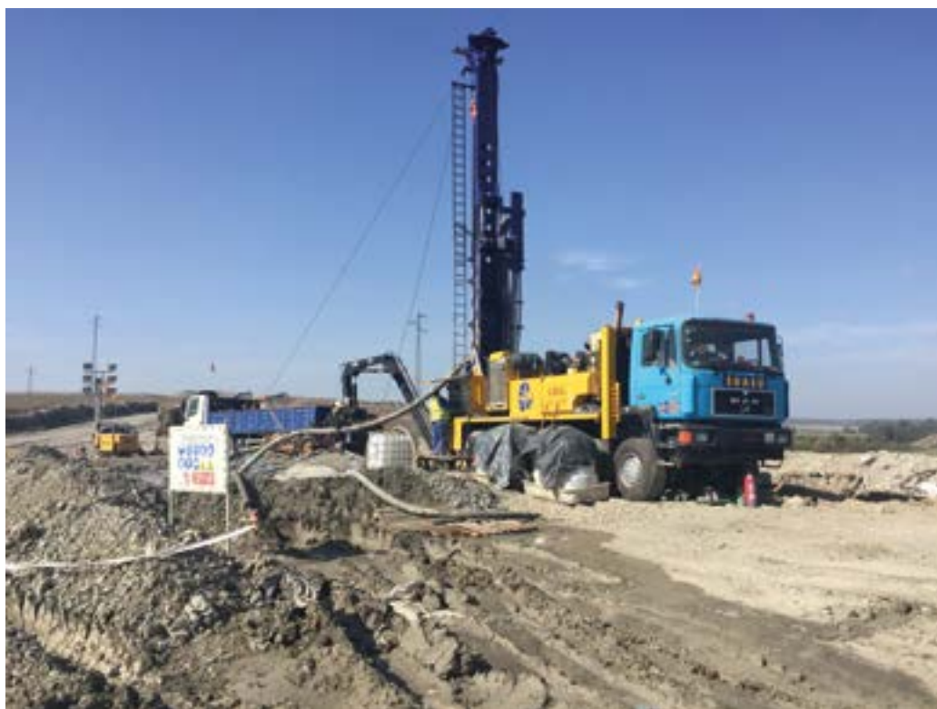
Perforación de un sondeo de captación de agua subterránea (Gilena, Sevilla). Autor: Juan Franqueza.
