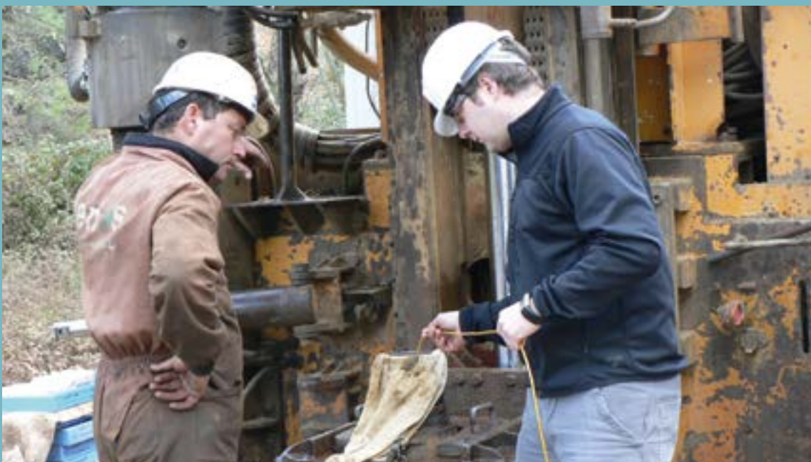
Ensayo de recuperación después de un bombeo con aire comprimido.
