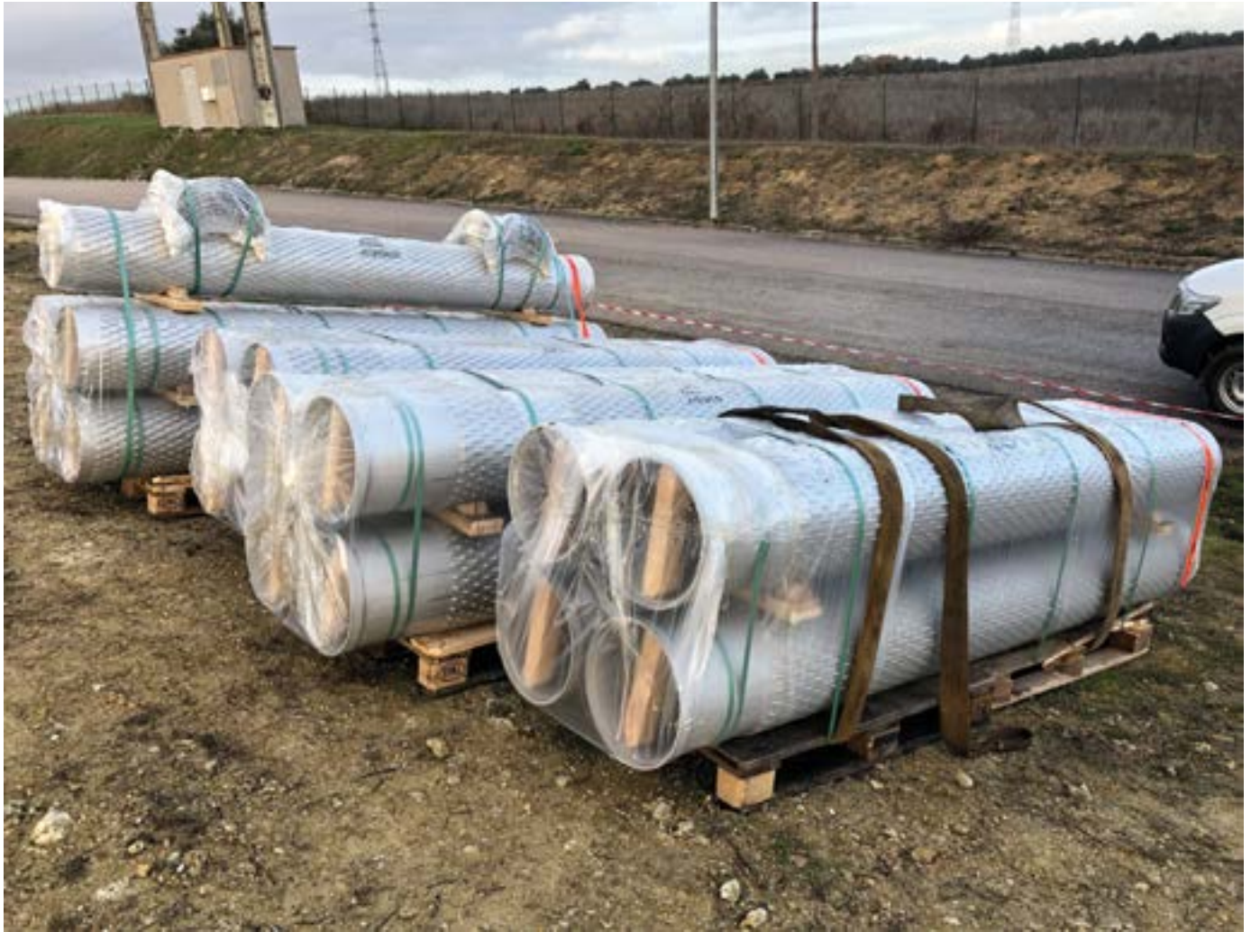
Tuberías de filtro puentecillo debidamente protegidas para su traslado hasta el pozo donde serán instaladas. Autor: Juan Franqueza.
