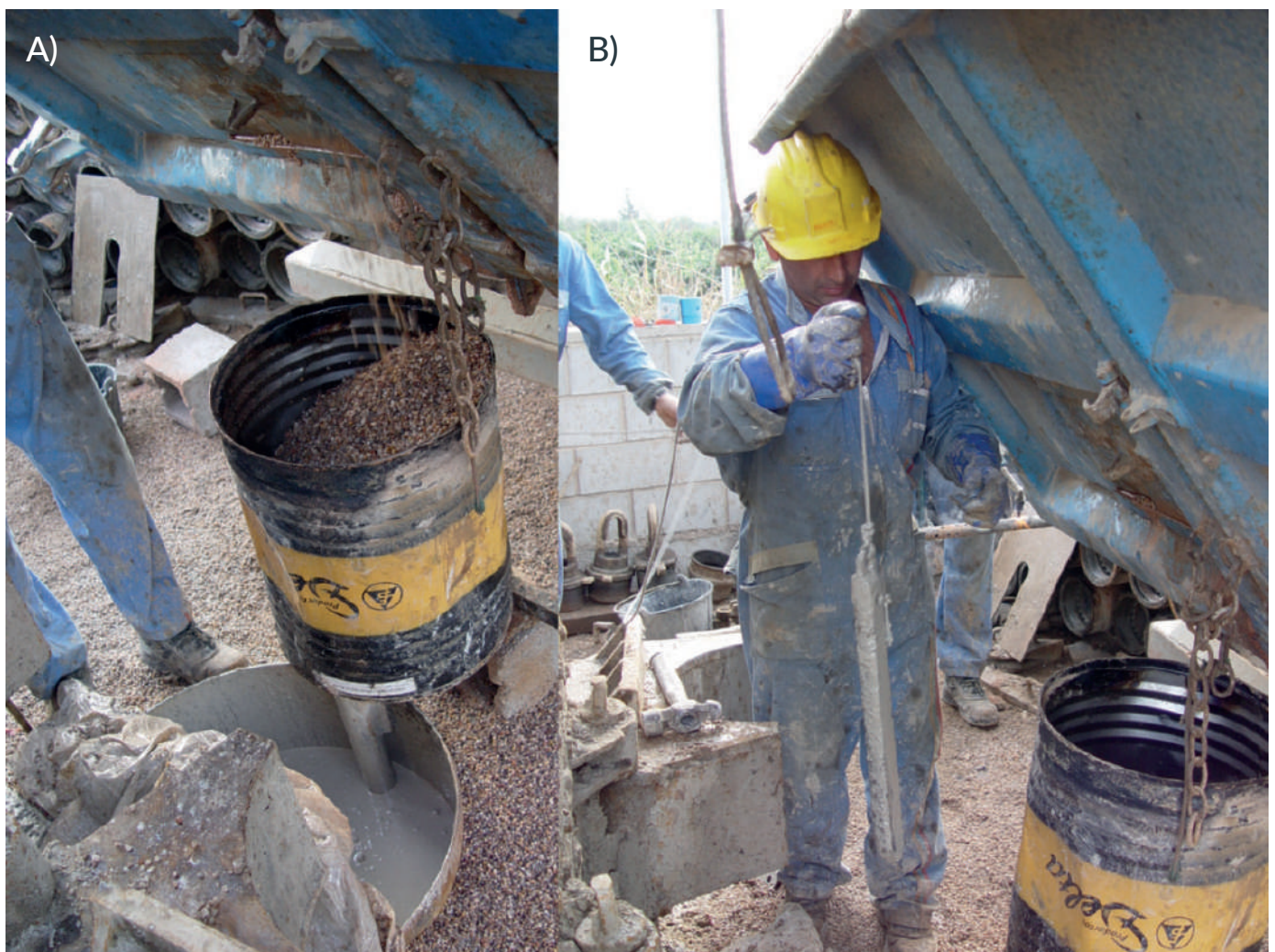
Figura 7.4.7. A) Colocación de un prefiltro de grava en un sondeo perforado a circulación mediante un tubo de engravillado. B) Comprobación de la profundidad del macizo de grava mediante plomada (Fotografías: Juan Antonio Hernández Bravo).
