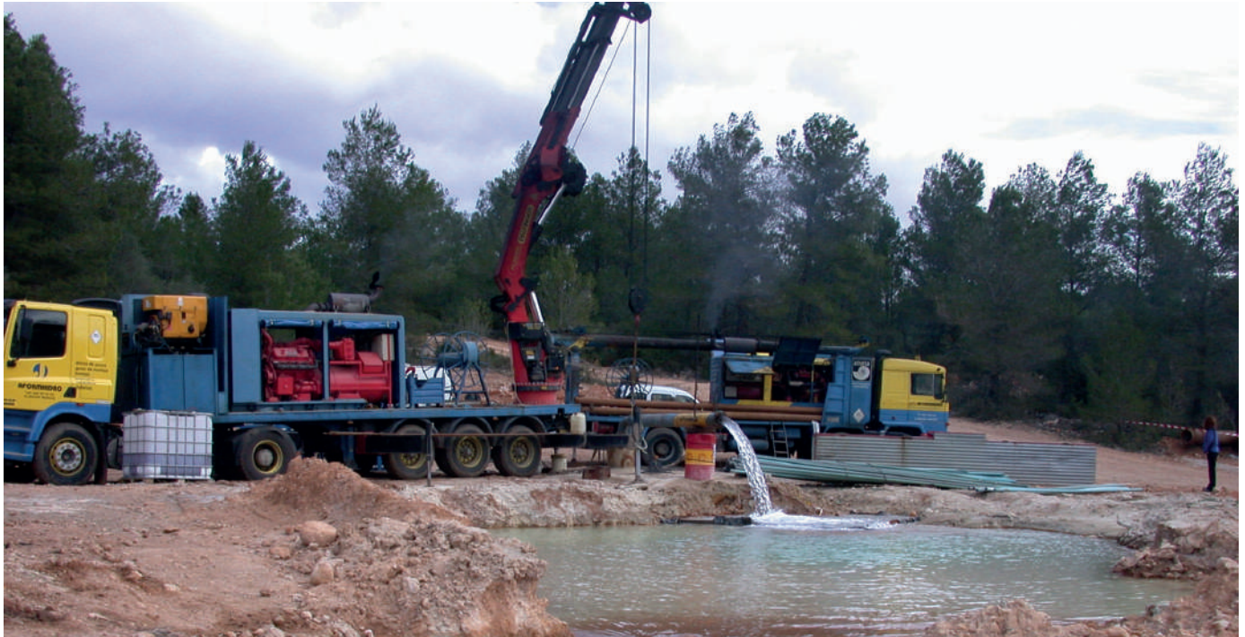
Ensayo de bombeo previo a la desinfección de un pozo. Autor: José Antonio Domínguez.
