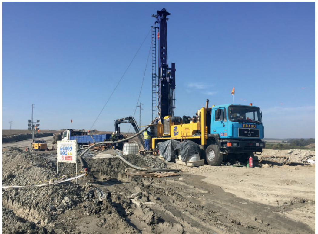
Perforación de un sondeo de captación de agua subterránea (Gilena, Sevilla). Autor: Juan Franqueza.
