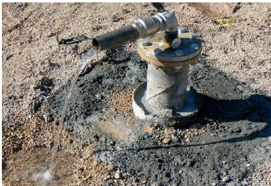
Detalle de la cimentación y el cierre de un pozo surgente.
