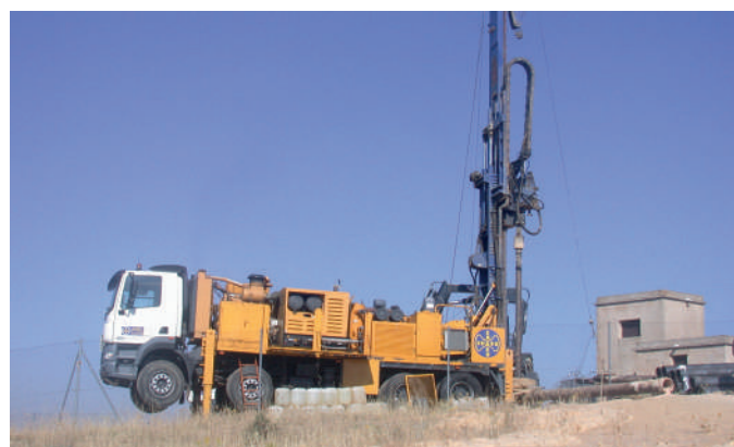
Equipo de perforación nivelado. Autor: José Antonio Domínguez.
