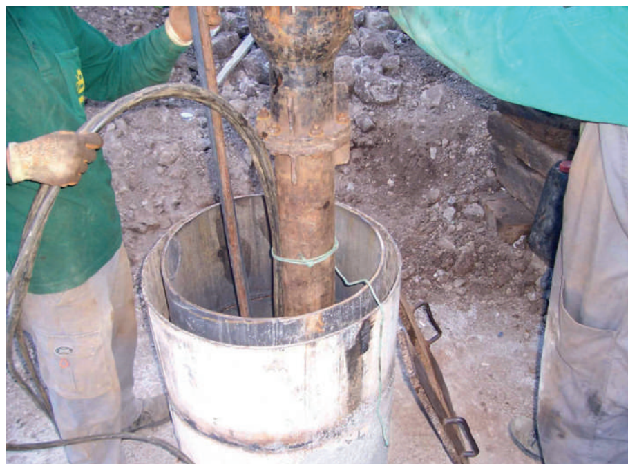
Detalle de la instalación de un tubo guía metálico, para la introducción de un hidronivel, y de un tubo guía de PVC, para la instalación de un sensor de presión automático. Autor: Sergio Martos-Rosillo.
