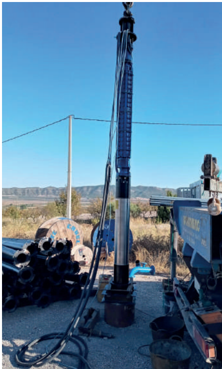
Instalación de un equipo de bombeo. Autor: Juan Antonio Hernández Bravo.
