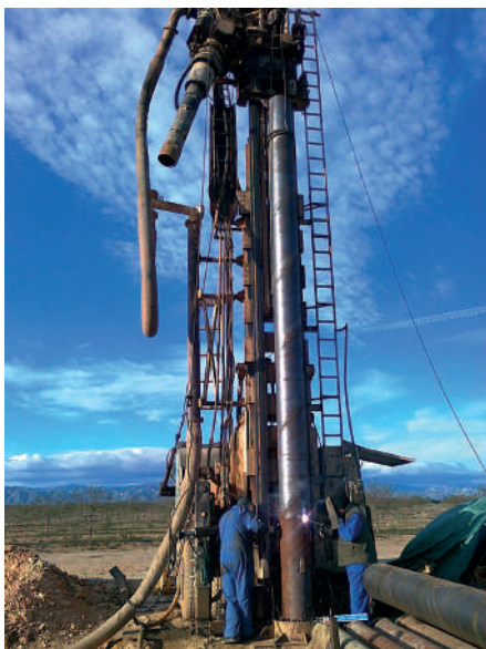
Soldadura para unión de tubería metálica.
