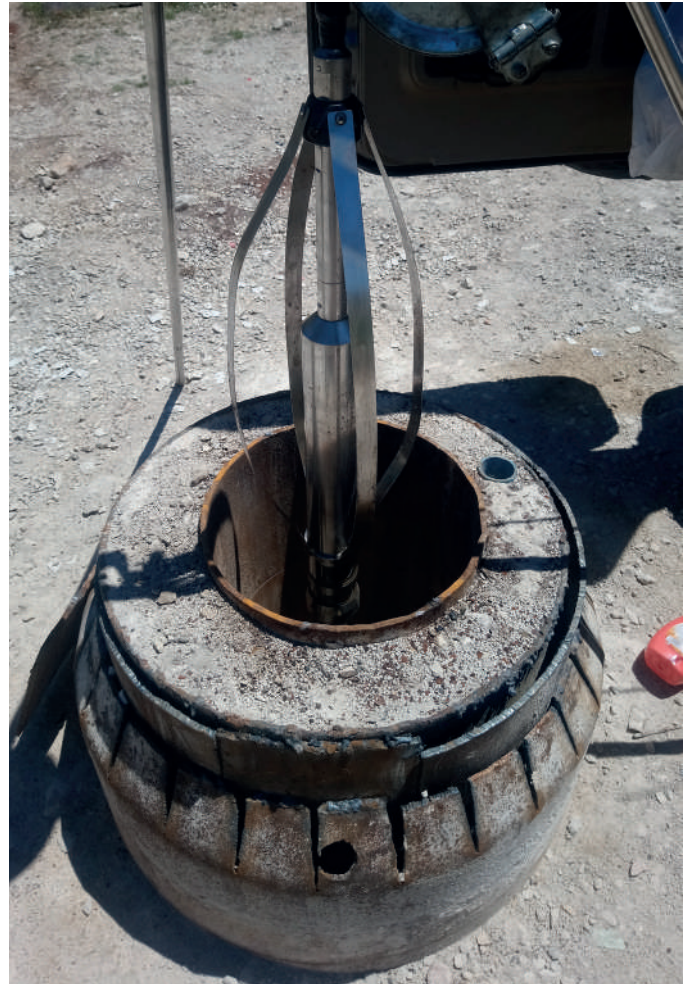
Registro geofísico de un sondeo terminado. Autor: Pedro Romero.
