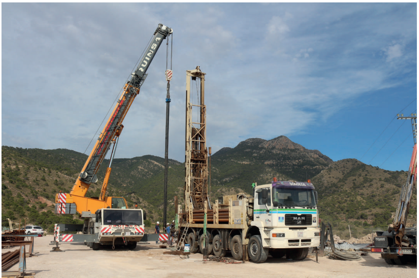
Entubación de un sondeo profundo. Autor: Francisco Martínez.
