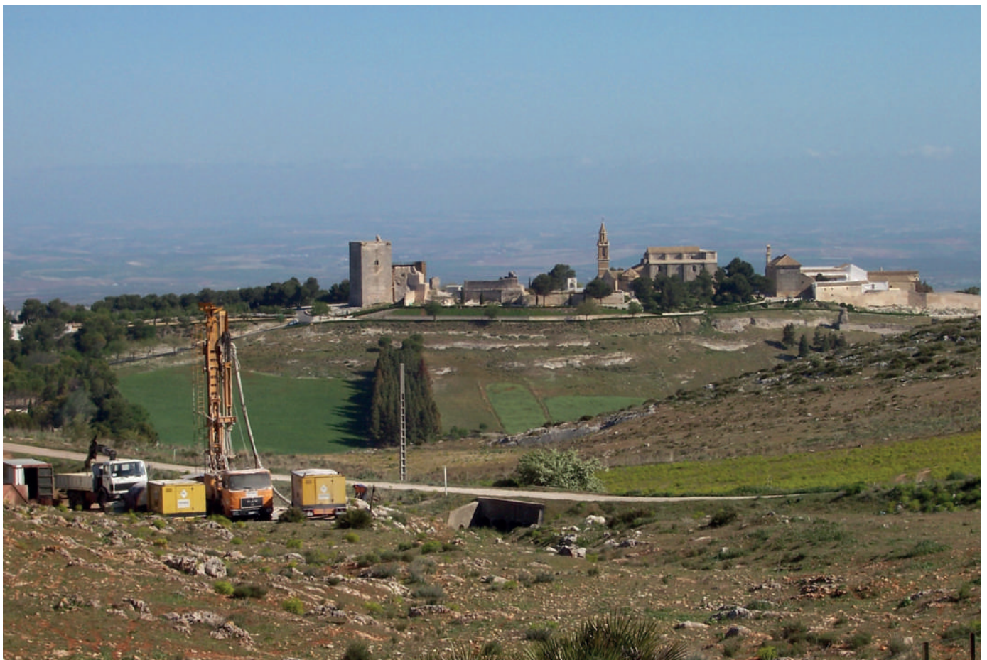
Equipo de perforación realizando un sondeo (Sierra de Estepa, Sevilla). Autor: Sergio Martos-Rosillo.
