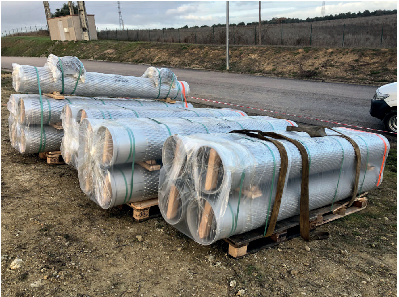
Tuberías de filtro puntecillo debidamente protegidas para su traslado hasta el pozo donde serán instaladas. Autor: Juan Franqueza.
