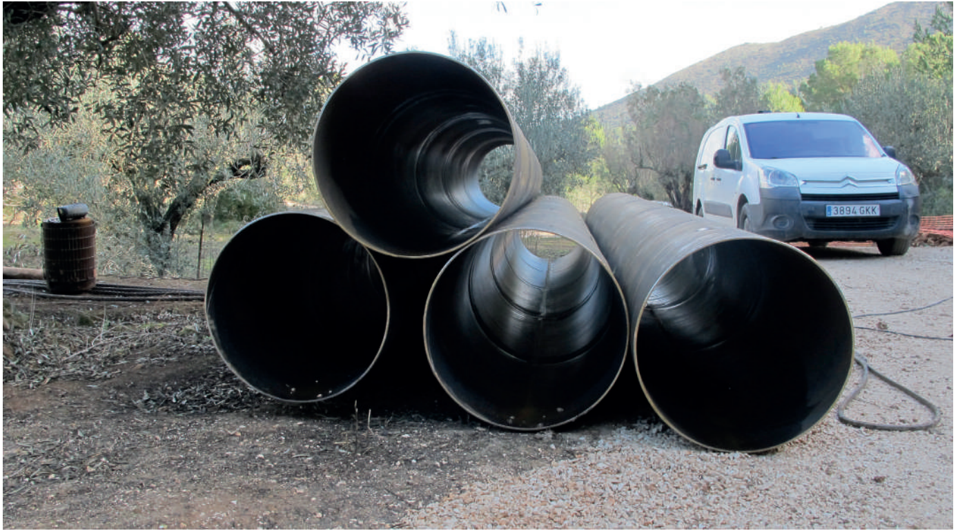
Acopio de tubería ciega de acero al carbono. Autor: Juan Antonio Hernández Bravo.
