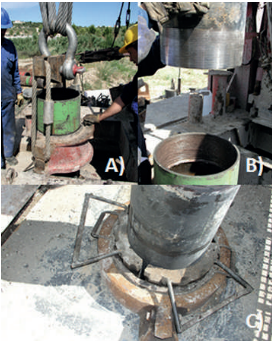
Figura 7.3.10. Operación de descenso de una tubería metálica unida mediante rosca.
