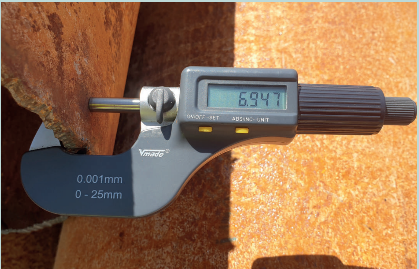
Comprobación del espesor de una tubería de revestimiento. Autor Juan Antonio Hernández Bravo.
