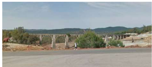
Foto 4: Panorámica de la zona a visitar. Puente-viaducto de Minas del Castillo, construido para salvar la vaguada del Arroyo Agrio.
