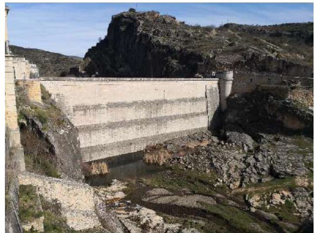
Figura 14. Vista actual del Pontón de la Oliva
