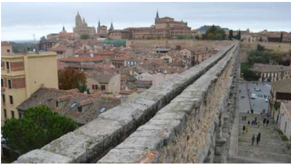
Figura 3. Tramo superior de la doble arquería del Acueducto de Segovia desde el lateral del canal en la plaza de Día Sanz, con el recinto amurallado de la ciudad al fondo. Foto: Andrés Díez Herrero.
