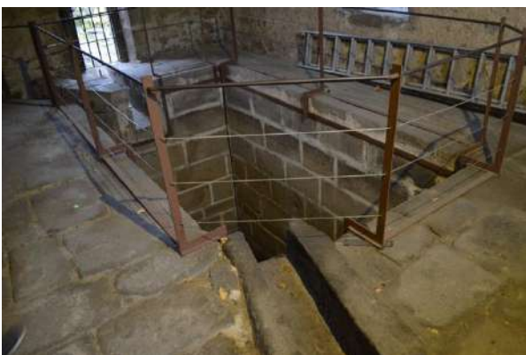
Figura 12. Interior de una de las casetas desarenadoras del Acueducto de Segovia (denominada de San Gabriel), con el canal de entrada, el de salida y el rebosadero, entrando y saliendo de la profunda piscina central de decantación de arenas, limos y arcillas. Fuente: Díez-Herrero (2017)
