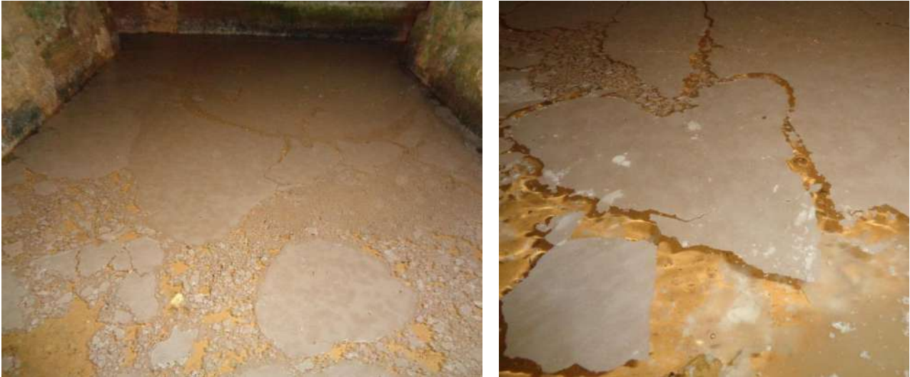
Figura 7. Fotografías de las finas láminas de precipitados de carbonato cálcico flotando sobre el agua que se forman en el depósito y las galerías de Fuente Vieja.
