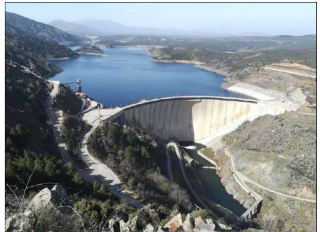
Fase explotación. Presa. 2020
