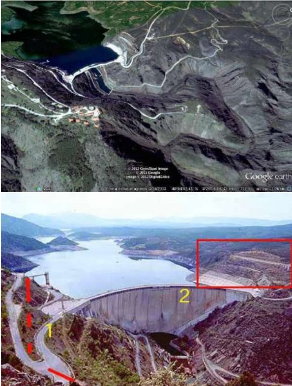
Figura 38. Problemas de inestabilidad en cada una de las laderas del embalse de El Atazar
