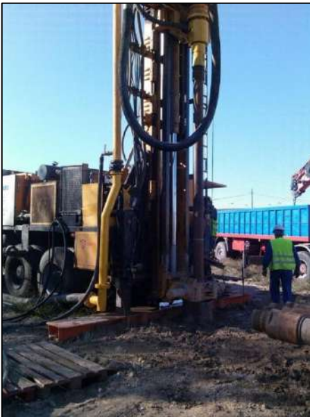
Figura 10. Emplazamiento de máquina de perforación por el sistema de rotoperusión
