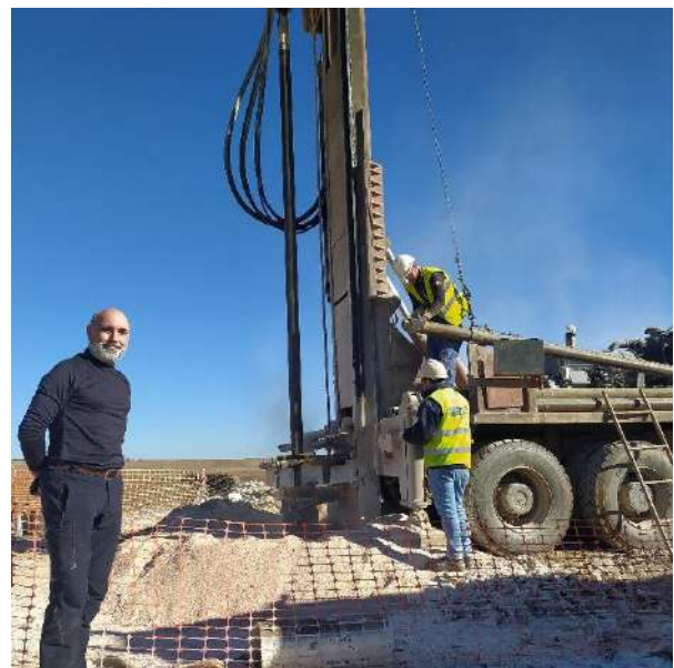
Foto 11: perforación de un sondeo a rotoperCUSión
