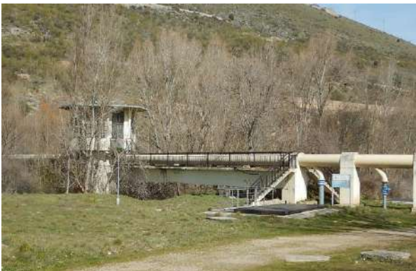
Figura 21. Pozo Ranney localizado en la confluencia de los ríos Lozoya y Jarama
