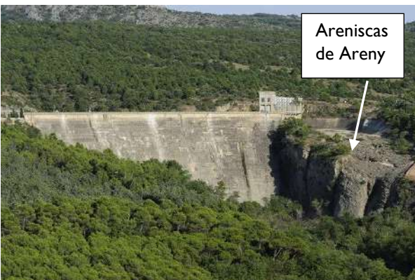
Figura 14. Vistas panorámicas de la presa de Talarn.
