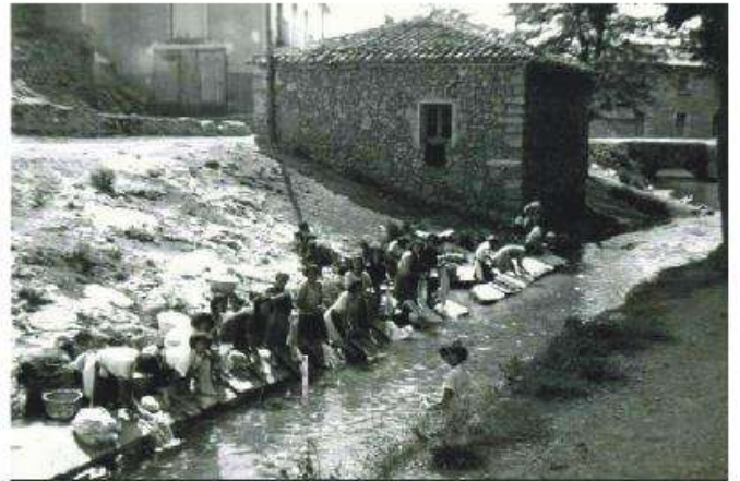
Figura 6. Foto de un día de colada en Cifuentes, a pocos metros del manantial en que nace el río Cifuentes. Al fondo a la derecha, el cauce llega a La Balsa bajo el puente (foto del primer tercio del siglo XX).
