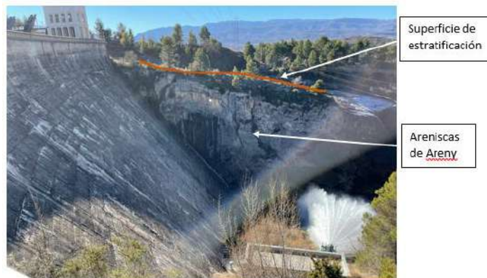
Figura 16. La fotografía muestra como el muro de la presa de Talarn se encaja en contacto directo en las areniscas de Areny. El canal de desagüe del embalse circula directamente por la superficie estratigráfica de las mismas.
