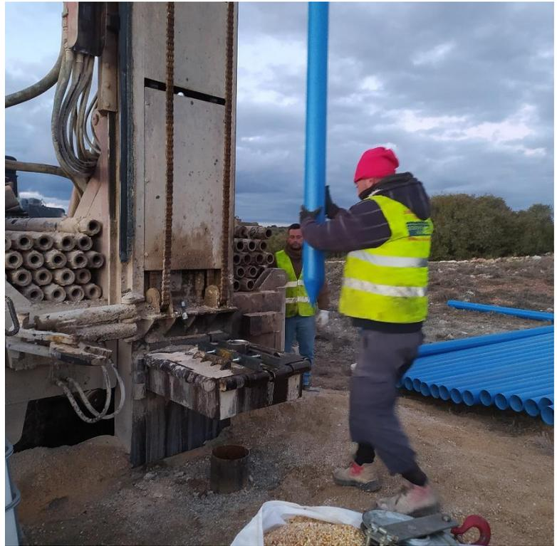
Figura 18: Entubación de un sondeo
