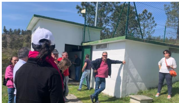
Visita al depósito de cabecera de una traída de agua en el municipio de Ponte Caldelas.
