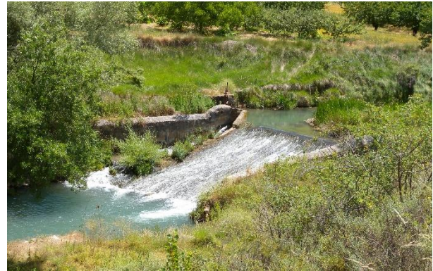
Presa de El Yesar
