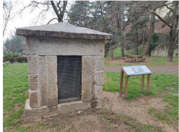
Figura 16. Arquilla de la C/ Cebadillas, 5 tras su restauración
