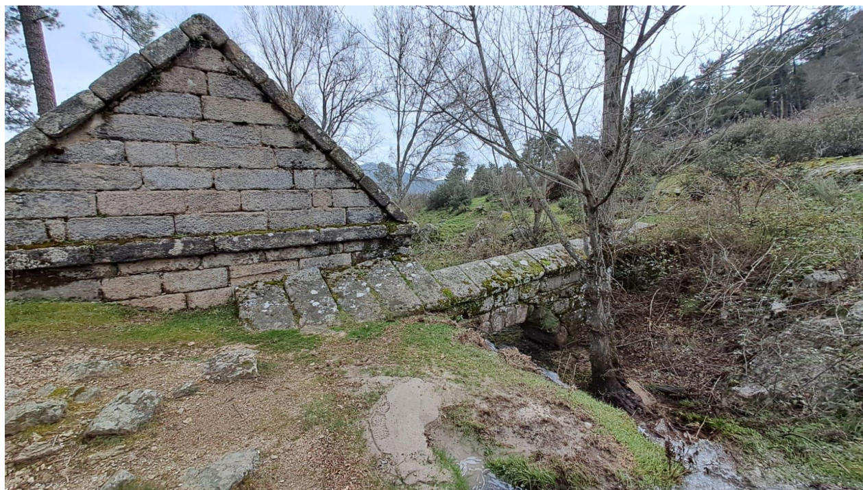
Figura 37. Vista trasera del arca del Helechal. En el lateral se aprecia el viaje de agua procedente del arca de San Juan
