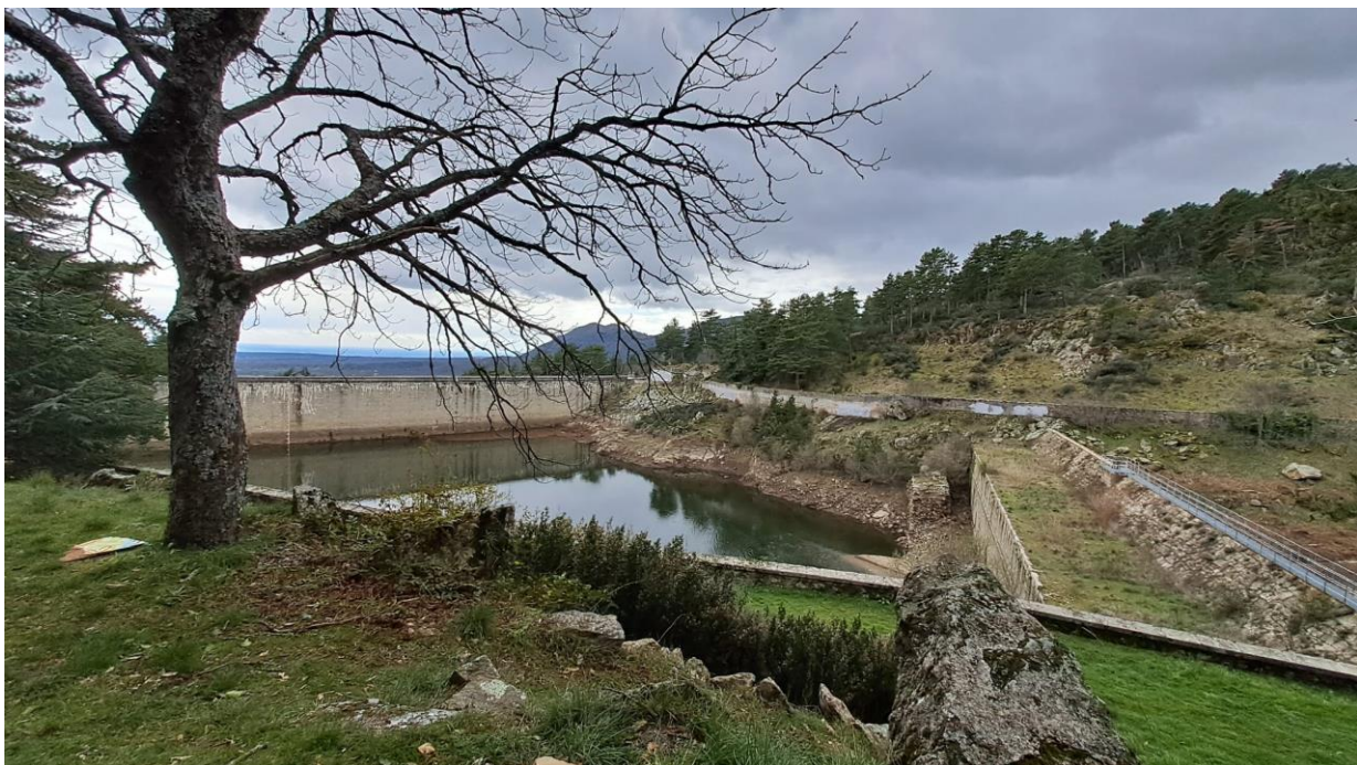
Figura 25. Foto panorámica de las tres presas del Romeral
