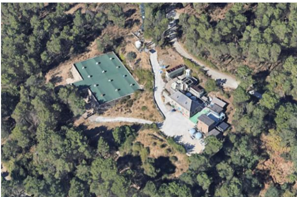
Figura 35. Vista de la Planta de tratamiento de agua potable de San Lorenzo de El Escorial, que potabiliza el agua procedente del embalse de La Aceña (imagen de Google Earth)
