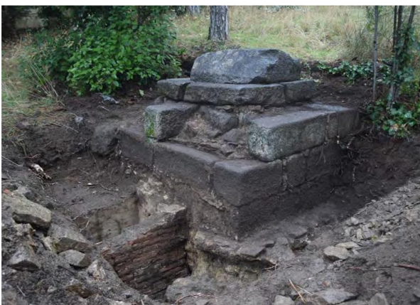
Figura 15. Estado de la arquilla de la C/ Carlos Ruiz, 4 antes de su restauración. Se aprecia en el lateral el vaso de ladrillo de la fuente
