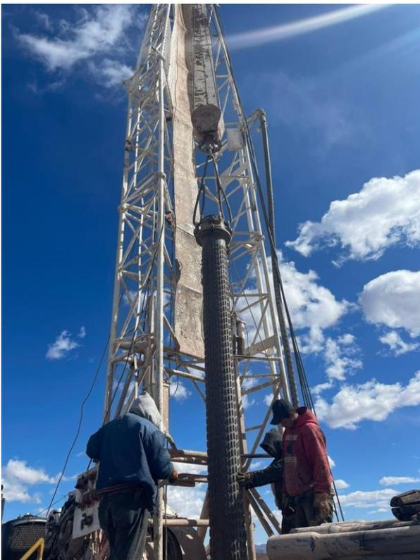
Foto 3: Componentes de un pozo de extracción de agua
