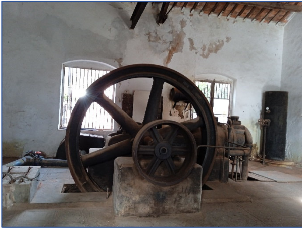
Figura 13. Maquinaria original del pozo del año 1924.
