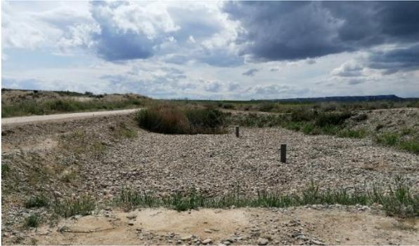
Figura 7. Imagen de la zona del humedal cubierta con gravas (2024). Corresponde a un 20% aproximadamente de la superficie total y se encuentra justo antes de la salida de agua del humedal tratada hacia el barranco.
