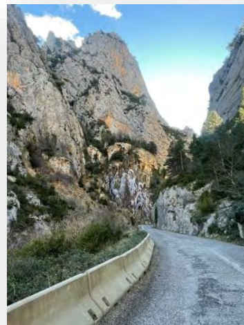
Figura 16. La Roca Argentería al fondo de la imagen. Obsérvese el fuerte buzamiento hacia el sur de la estratificación por encima de la surgencia.
