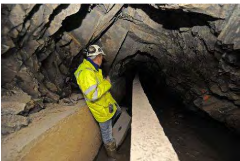
Figura 11. Últimas obras de reparación en el túnel de la Cobertoria (2015), en el tramo Cortes-Llamo del "Canal del Aramo"
