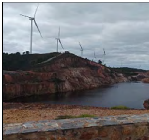
Figura 1. Fotografía de Filón Centro desde el punto de encuentro.
