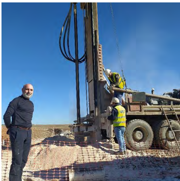
Foto 11: perforación de un sondeo a rotopercusión
