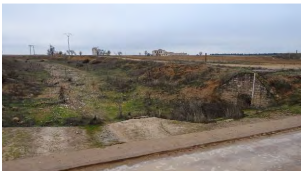
Foto 10. Uno de los sondeos de recarga del sencillo dispositivo construido a finales de la década de 1990 en Alameda de Cervera.
