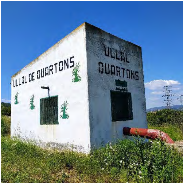
Foto 10: captación de agua subterránea.
