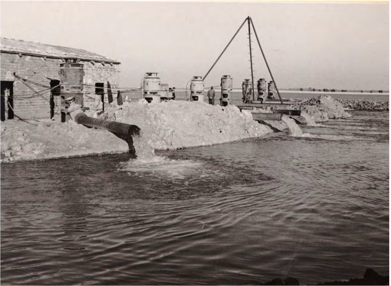
Foto 18. "Aforo simultáneo de una batería de sondeos en el Sector III de la Zona de La Mancha (Herrera de La Mancha). En esta batería se han obtenido 660 l/s, habiéndose realizado por los equipos del I.N.C. en este sector 22 sondeos con un caudal total de 2.080 l/s. En el Sector I (Llanos del Caudillo) se han construido 25 pozos ordinarios con los correspondientes sondeos laterales obteniéndose un caudal de 2.030 l/s. En el sector II (Cinco Casas) se han construido 27 pozos que dan un caudal de 2.735 l/s". (Fuente: Instituto Nacional de Colonización, 1964)
