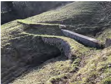
Figura 10. Canales de Llamo (inferior, en piedra) y de Cortes-Lindes (superior en hormigón) en las cercanías del pueblo de San Adriano (Riosa).
