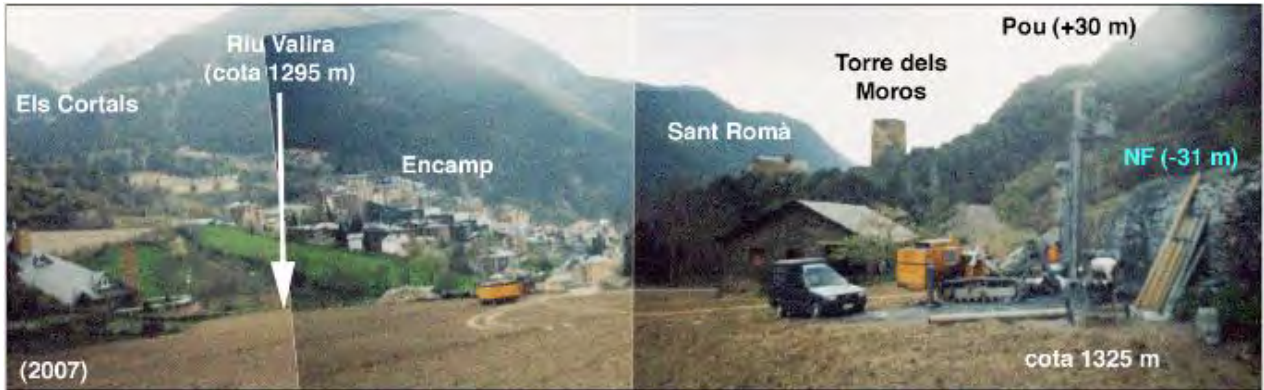
Construcció d'un pou. El nivell freàtic està connectat a l'aquífer al·luvial
