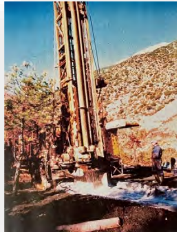
Figura 8. Perforación del sondeo de Cabó situado a unos 250 m al oeste del núcleo del Vilar. Al fondo de la foto calizas del Cretácico inferior (Barremiense) del sinclinal de Cabó – Collegats (flanco norte buzando hacia el sur). El sondeo tiene una profundidad de 293 m. Hasta los 85 m se perforaron margas impermeables, a partir de donde los materiales perforados fueron margas calcáreas o calizas negras, algunas con ligero olor a hidrocarburo. El caudal obtenido durante la perforación fue de unos 20 m 3 /h (Pascual, 1993).
