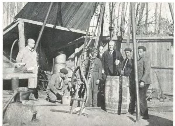
Foto 9. “Un ensayo con fluoresceína, en el taladro de un sondeo profundo en la Alameda de Cervera”. (Eduardo Hernández-Pacheco)
