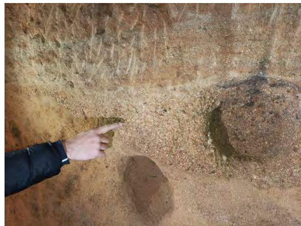
Figura 7 – Detalle de la “toba” que forma las paredes y marcas de la excavación de las galerías en ella. Fotografía de M.F.Vicente.
