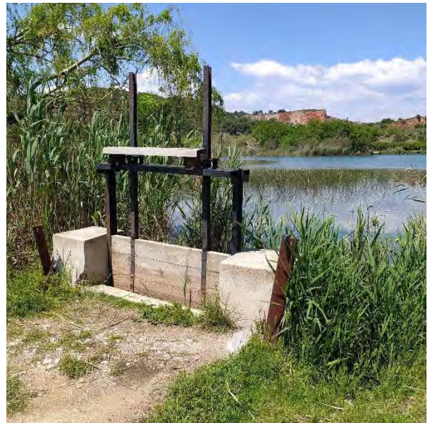
Foto 18: Compuerta de regulación de las aguas dels Estanys.
